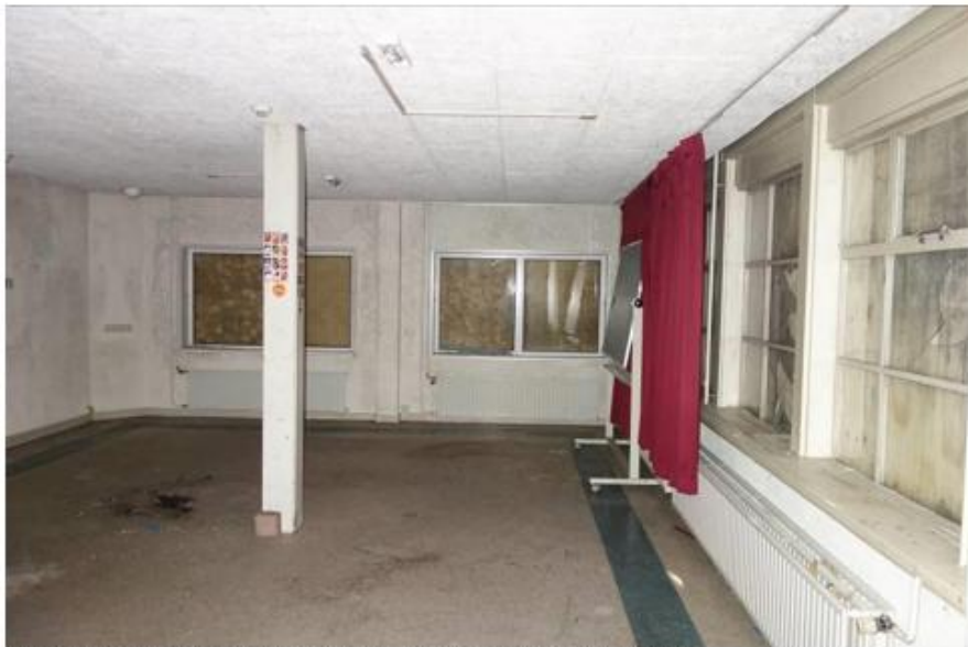
Interieur van de vm. lighal aan de zuidzijde van het hoofgebouw. (MAB, 2019)
