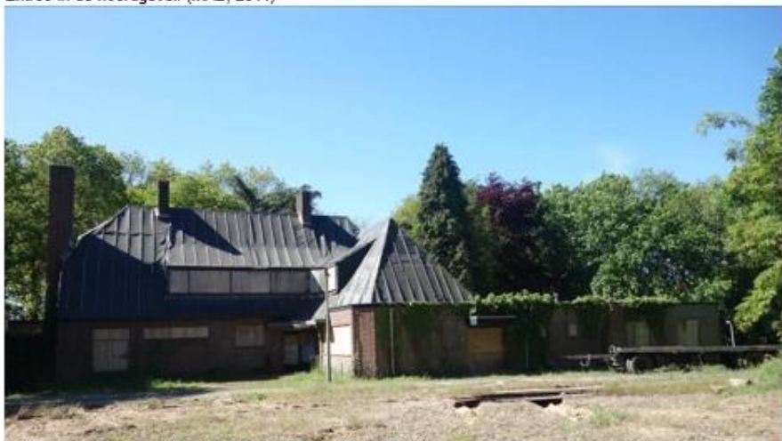
Zicht op de noordgevel van het hoofgebouw. (MAB, 2019)
