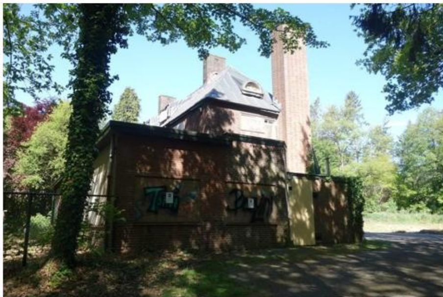
Zicht op de oostgevel. (MAB, 2019)
