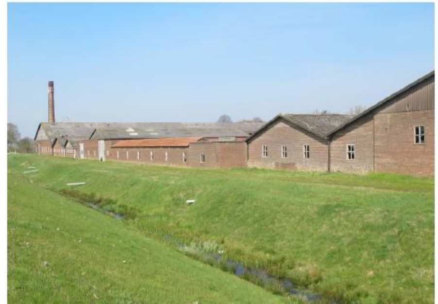
De zuidgevels van de gebouwenclusters gezien vanaf de dijk. FH MAB 2014
