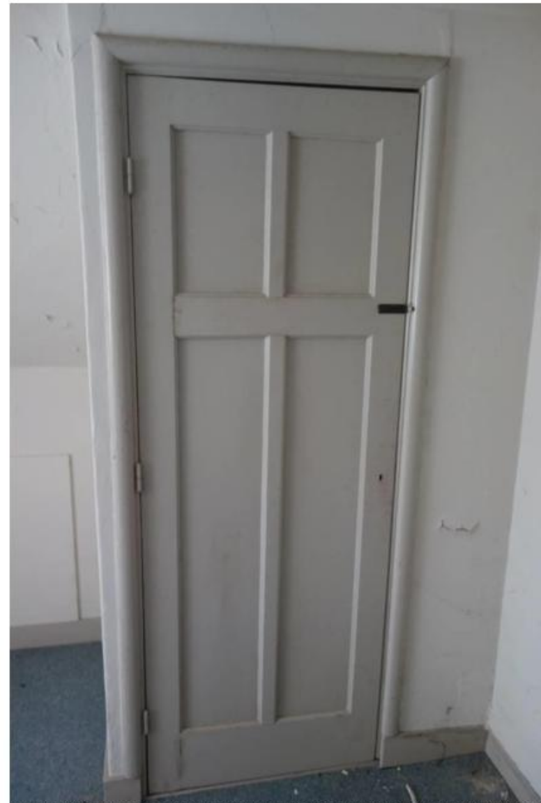
Oorspronkelijke houten paneeldeuren en afgeronde kozijnen op zolder, hoofgebouw. (MAB, 2019)
