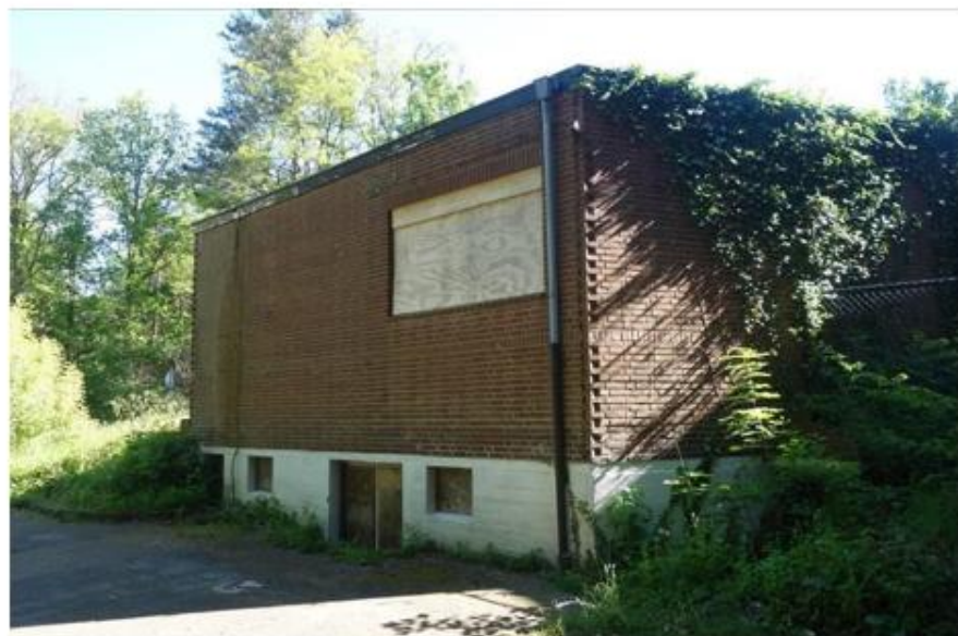
Zicht op de westgevel van het hoofgebouw. (MAB, 2019)
