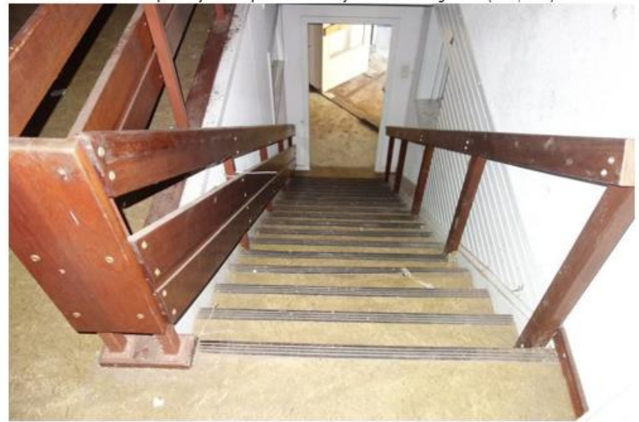
Niet oorspronkelijke trap naar de verdieping van het hoofgebouw. (MAB, 2019)
