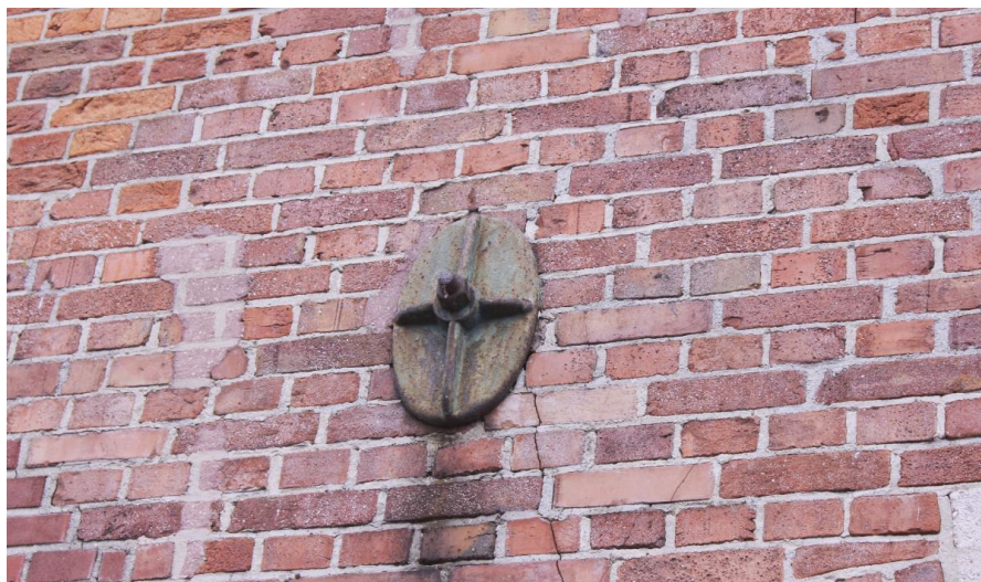
Rozetanker in een van de gevels.
