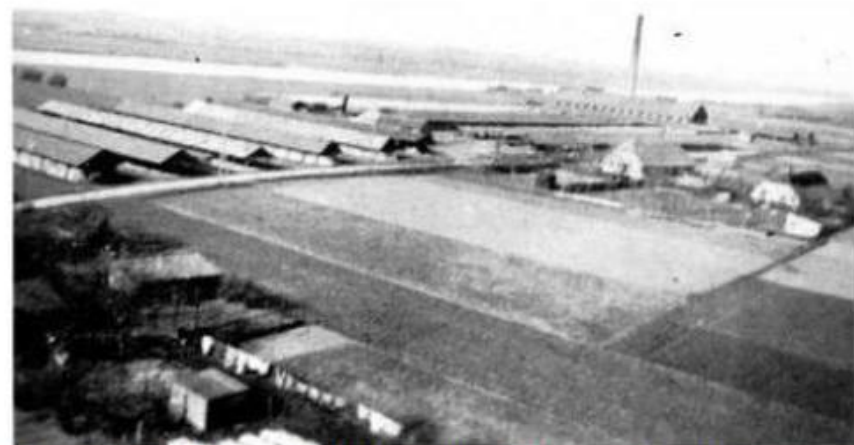
Vogelvlucht van de N.V. Steenfabriek Milsbeek in 1943, gefotografeerd vanuit een toen net gereed gekomen electriciteitsmast door Frans Huisman. Links op de voorgrond de reeksen haaghutten en op de achtergrond de ringoven met schoorsteen. (foto uit De Alde Milsbèk)
