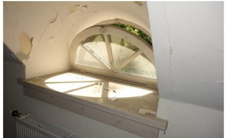
Raam van een van de oorspronkelijke dakkapel aan de oostzijde van het hoofgebouw. (MAB, 2019)
