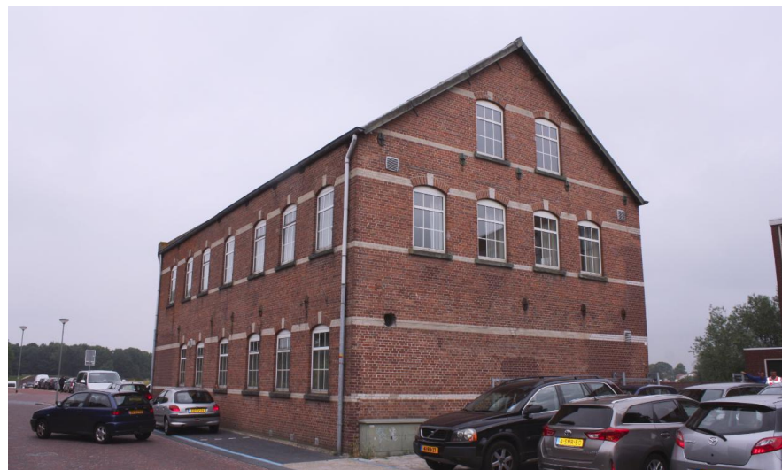
Zicht op de oostgevel.
