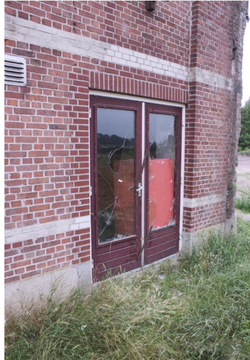
Huidige entree in de zuidgevel uit 1983.
