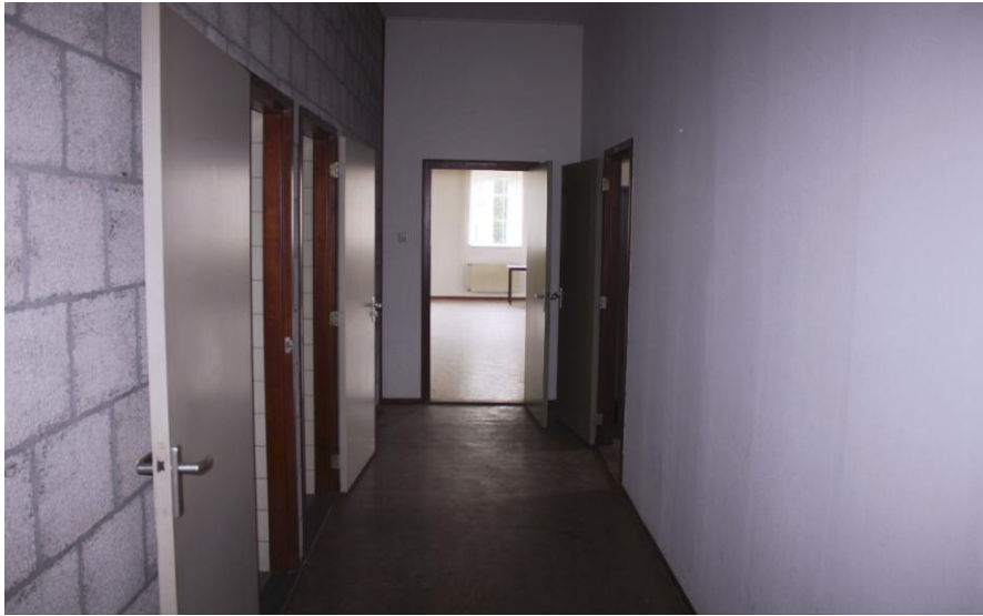
De middengang op de verdieping aan de westzijde van het gebouw, gezien richting het oosten.
