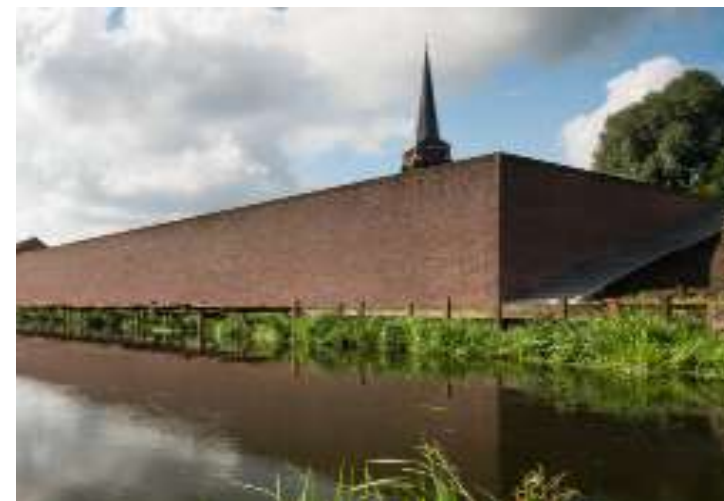
2. huidig beeld van de hoek van de kademuur
