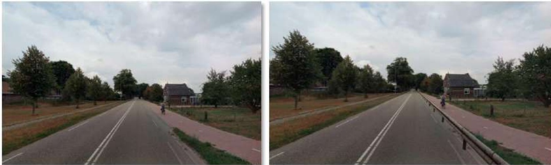
Figuur 4.2 | Fotovisualisatie toepassing aluminium afscheiding met hout-look tussen fietspad en Hoofdstraat. Links huidige situatie, rechts situatie met afscheiding
