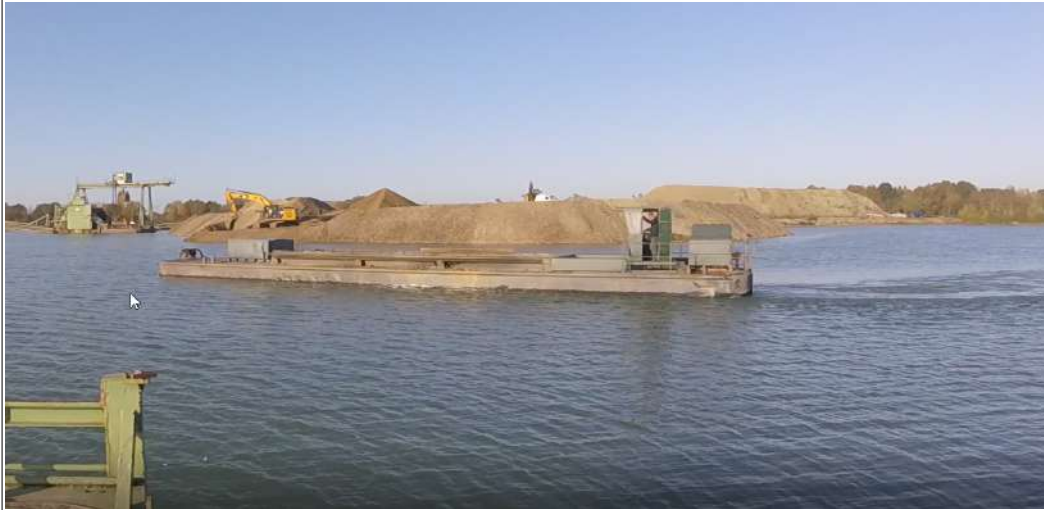
f4.1 Weergave activiteiten – varen onderlosser, laden van een onderlosser met behulp van een mobiele kraan (de installatie op de achtergrond behoort niet tot de beoogde activiteiten in Heijen), storten grind met een mobiele kraan.
