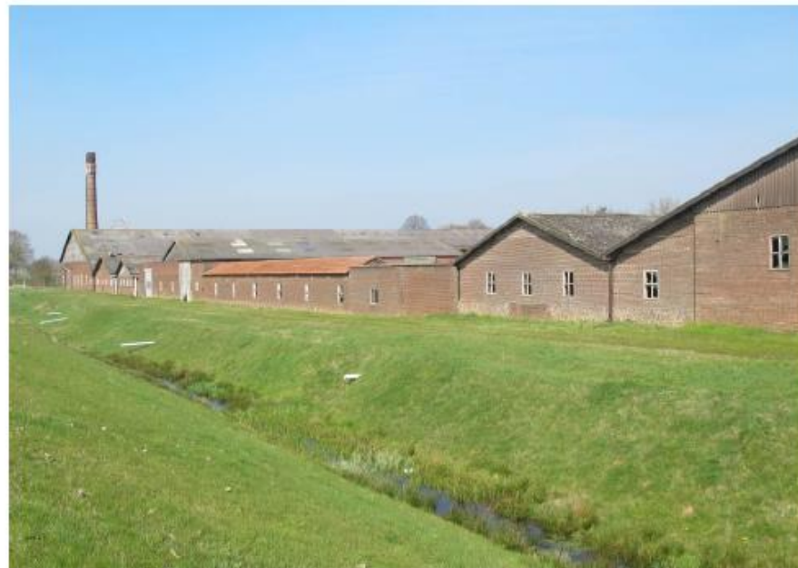
De zuidgevels van de gebouwclusters gezien vanaf de dijk. FH MAB 2014
