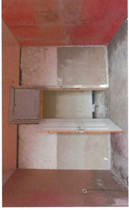
Afbeelding 73 Een van de zustervertrekken op de 1 e verdieping; de binnendeuren zijn over de gehele verdieping vervangen geweest door nieuwere exemplaren
