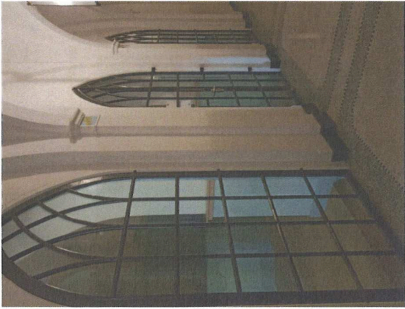
Afbeelding 48 Zicht op de huidige receptieruimte (links) vanuit de gang. In de wand zijn een drietal spitsboogvormige (refererend naar de kapel) glaspartijen aangebracht, deze zijn van een latere periode.
