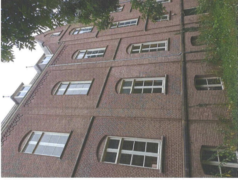
Afbeelding 30 Achtergevel (noordgevel) Zusterhuis, met eveneens een topgevel ter plaatse van het trappenhuis. In iedere travee en op iedere bouwlaag zijn de oorspronkelijke achtruitse raamvensters nog aanwezig. In de kapverdieping is ter plaatse van iedere travee een dakkapel aanwezig.
