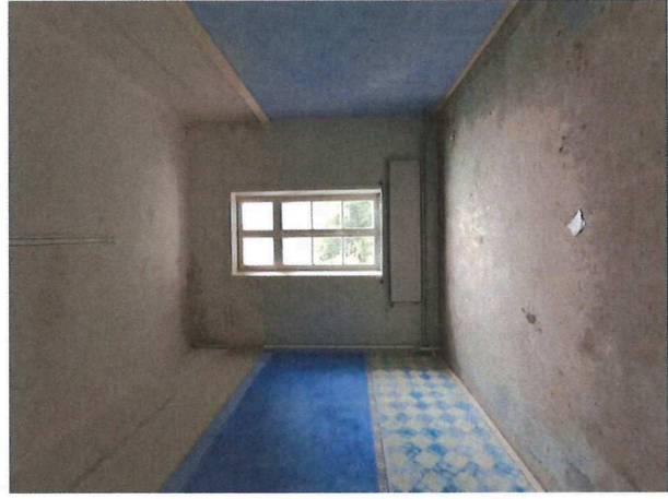
Afbeelding 68 Een van de zustervertrekken op de 1 e verdieping (vloer in houtgraniet)
