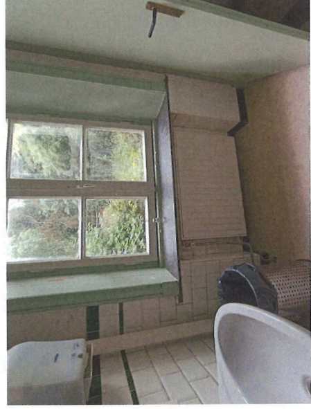
Afbeelding 72 Toiletruimte op de begane grond, de linoleum vloerbedekking en het wandtegelswerk stamt uit een latere periode
