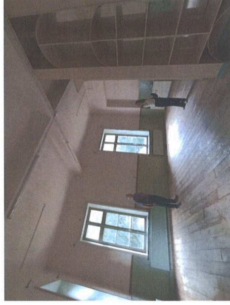
Afbeelding 63 De voormalige discotheek en oorspronkelijke keuken. Tegenwoordig zijn de vloeren bedekt met houten planken. Rechts onder in beeld het barmeubel en de doorgebroken muur. Het plafond is voorzien geweest van groen tegelwerk, waarvan de pleisterrestanten nog zichtbaar zijn. In de ruimte is duidelijk de betonnen hoofddragconstructie zichtbaar.
