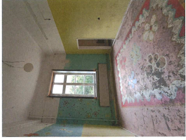
Afbeelding 70 Een van de zustervertrekken op de 1 e verdieping (vloer in houtgraniet, later beschilderd)
