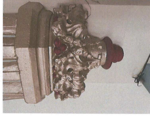
Afbeelding 60 Detail van een sluitstuk uit savonnières-steen van het gewelf
