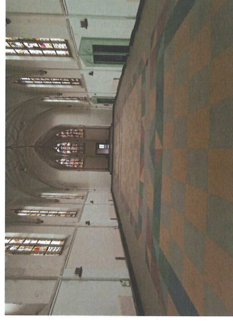
Afbeelding 61 De vloer in de kapel is bedekt met linoleum uit een latere periode, met daaronder mogelijk nog de tegelvloer
