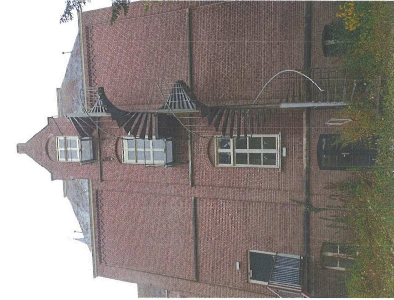
Afbeelding 29 Oostgevel Zusterhuis, met centraal een topgevel en aan weerszijden een blind uitgevoerde travee. Op de begane grond is het oorspronkelijke raam nog aanwezig; op de eerste en tweede verdieping werden deze later vervangen door nieuwere deuren met bordes en vluchtrap.
