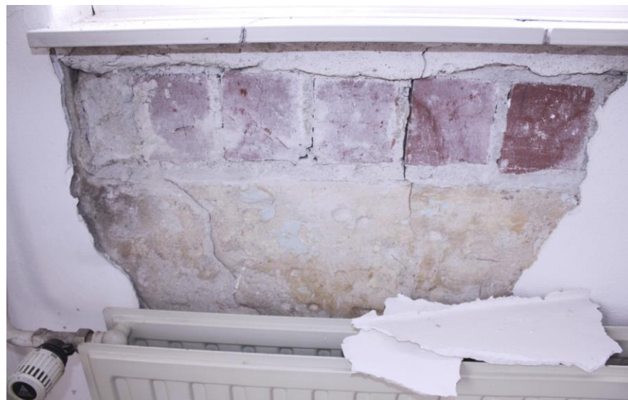
Achter het stucwerk is nog een oudere afwerklaag aanwezig.
