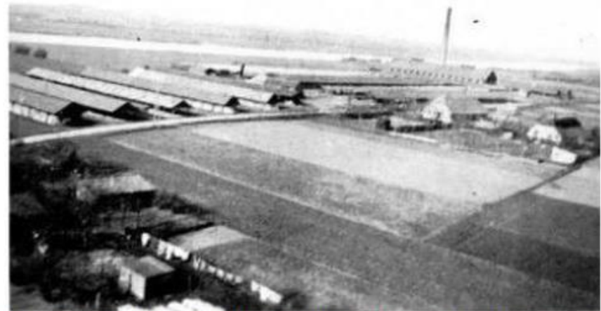
Vogelvlucht van de N.V. Steenfabriek Milsbeek in 1943, gefotografeerd vanuit een toen net gereed gekomen electriciteitsmast door Frans Huisman. Links op de voorgrond de reeksen haaghutten en op de achtergrond de ringoven met schoorsteen. (foto uit De Alde Milsbêk)
