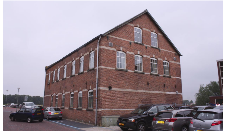
Zicht op de oostgevel.
