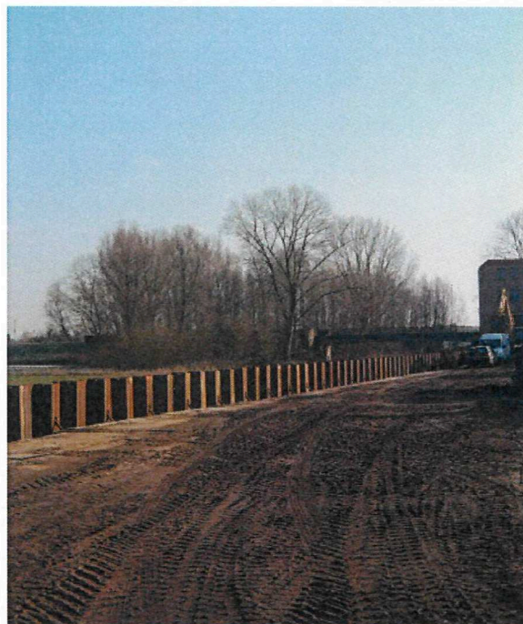
Werkzaamheden aan de waterkerende constructie
