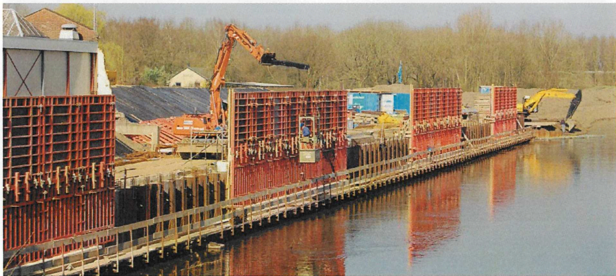
Werkzaamheden aan de muur
