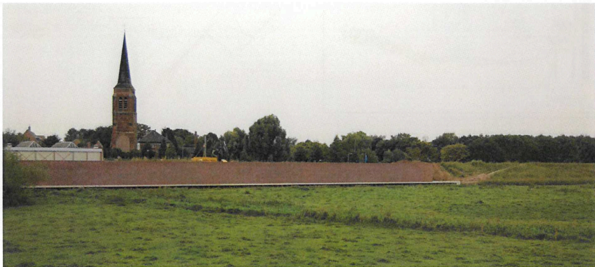
De nieuwe muur
