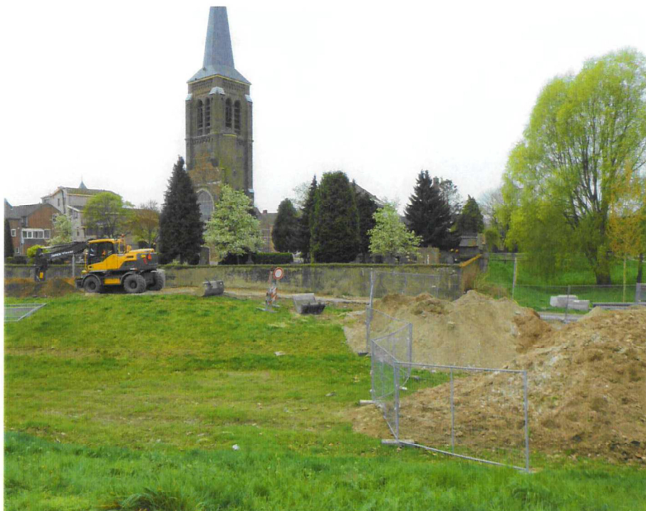
Afb. 2.13 Aanleg van de hemelwaterafvoer ter hoogte van de Genneperhuisweg. Uiterst rechts, tussen de kerkhofmuur en de wilgenboom de voormalige binnenste gracht aan het Melkstraatje. Foto richting het zuidwesten.
