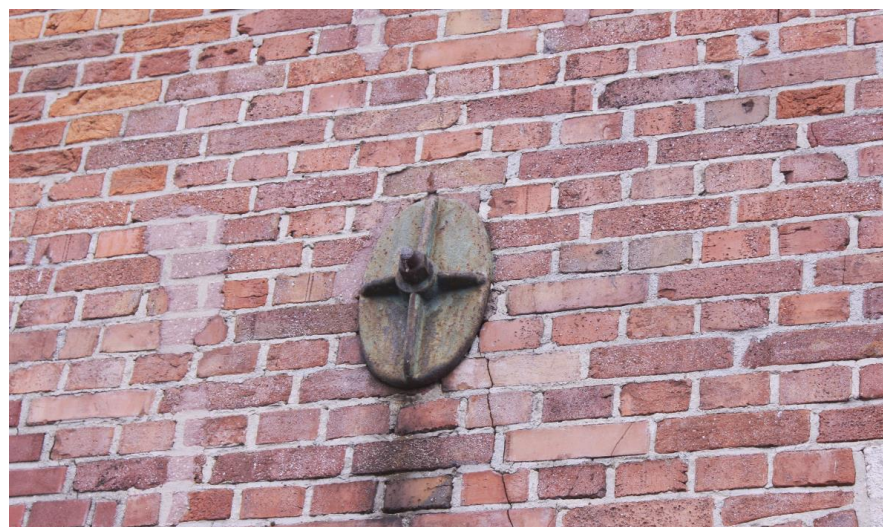
Rozetanker in een van de gevels.
