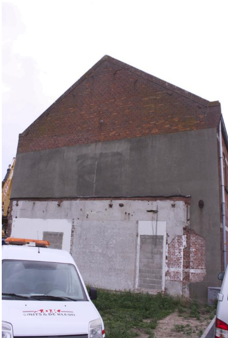
Zicht op de westgevel
