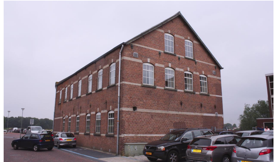
Zicht op de oostgevel.
