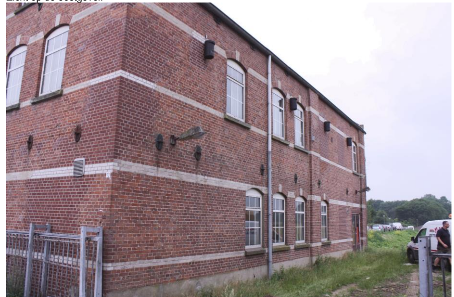
Zicht op de noordgevel met het vulwerk in de voorste hoek ter plaatse van de voormalige loopbrug.
