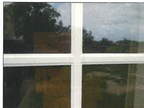
Beglazing voorzien van roede in de luchtspouw
