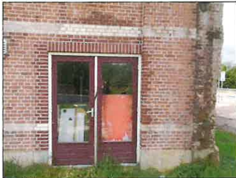
Schilderwerk houten gevelkozijn
