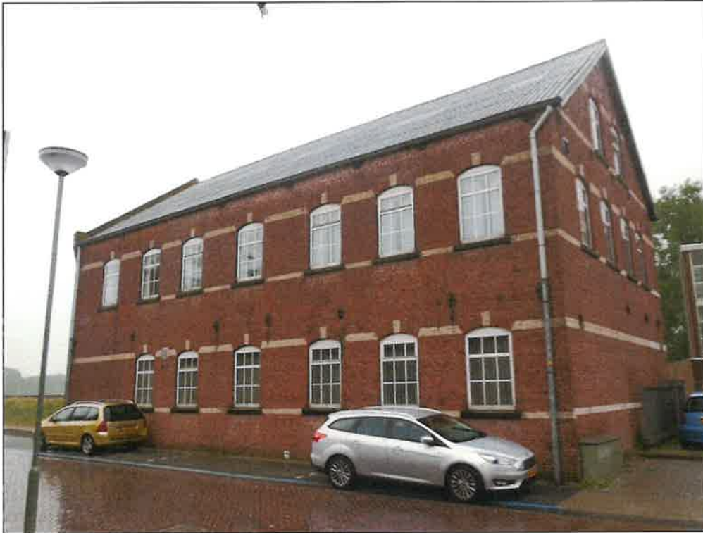
Afbeelding 5, Overzichtsfoto Noordwest gevel
