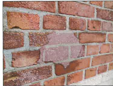
Gerepareerd voeg- en metselwerk
