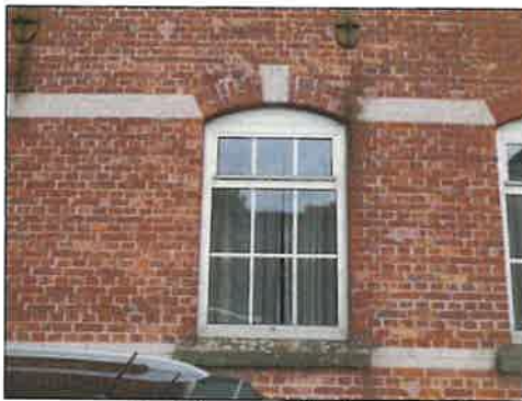
Bestaande aluminium gevelkozijnen
