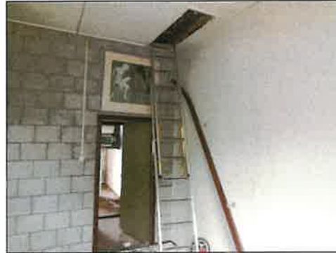
Toegangsluit naar de zolderverdieping
