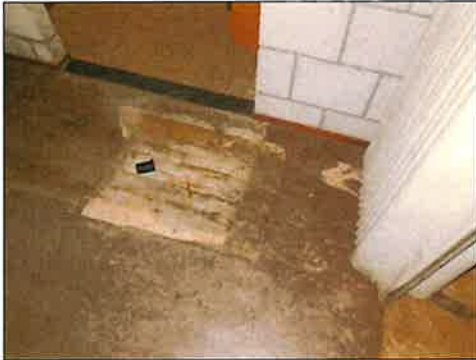
Sparing in de vloerafwerking op de begane grond, houten vloerdelen zichtbaar
