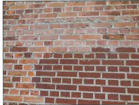
Verschillende formaten gevelstenen
