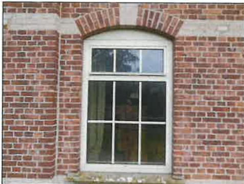
Kunststof gevelkozijnen v.v. geïsoleerde beglazing
