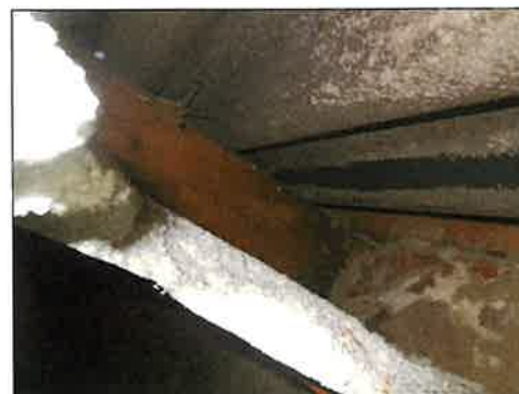
Houten gording, isolatie en golfplaten
