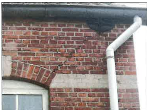
Diagonale scheur (trapsgewijs)
