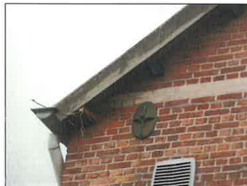
Delen vervangen door wind- en dekveren
