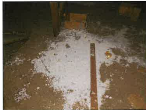
Isolatiemateriaal op de vloer
