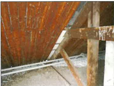
Dakconstructie aan de binnenzijde afgetimmerd
