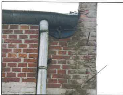
Zinken mastgoot opgehangen aan gootbeugels
