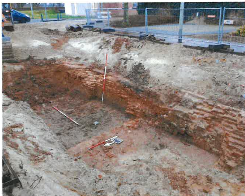
Afb. 3.25 Resten van de keldervloer met zijgevel aan de Haspel. Foto richting het zuidoosten.
