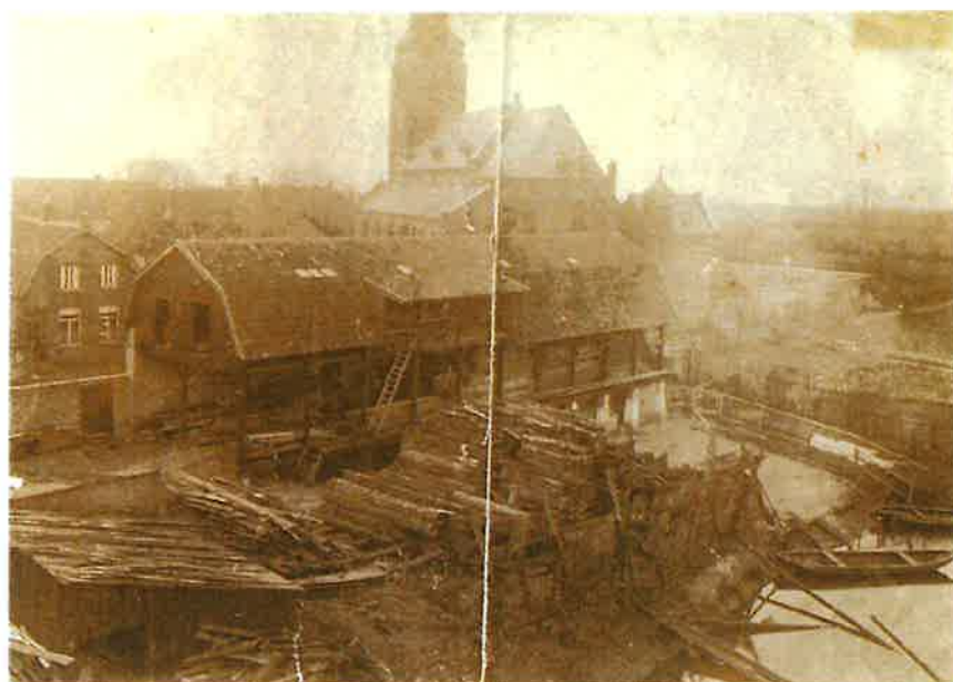
Afb. 3.19 Op een aanzichtfoto van Gennepe daterend rond 1902 zijn tegen de kerkhofmuur (mogelijk voormalige stadsmuur) meerdere steunberen zichtbaar. De steunberen zijn na de Tweede Wereldoorlog onder het puinpakket bedolven (Fotogalerij Gennepe).
