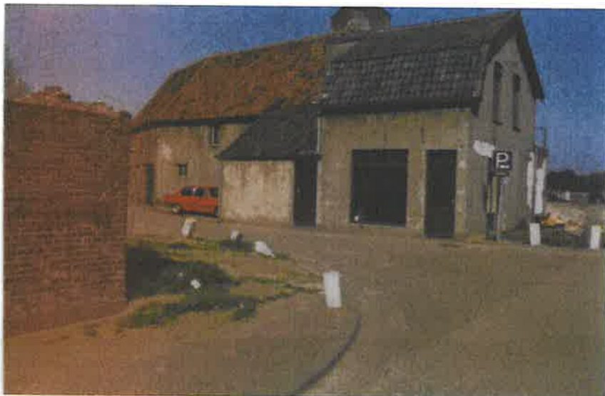
Afb. 2.10 Foto van de bebouwing op de hoek van de Gennepershuisweg en Haspel in 1992. Uiterst links de ongepleisterde muur van de schuur, in het midden de vermoedelijke pottenbakkerswoning en uiterst rechts een laat negentiende-eeuws woonhuis (Fotogalerij Gennep 2016).
