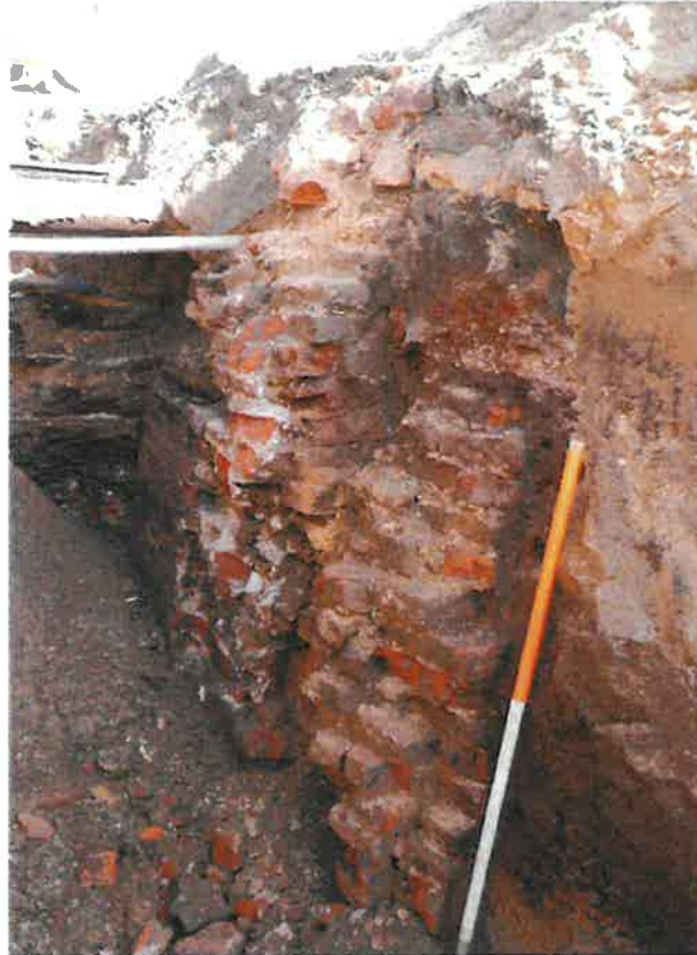
Afb. 3.17 Doorbraak door de stadsmuur tijdens de begeleiding. Helemaal links is de steunbeer zichtbaar. Vanwege de verschillende soorten mortel is het onderscheid tussen de veertiende- en achttiende-eeuwse bouwphase goed zichtbaar. Foto richting het zuidoosten.
