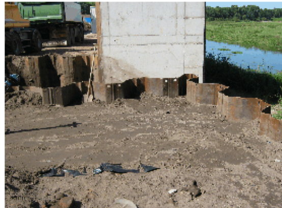
(boven) ontgraving en aanvulling trappartij noordwestelijk van Gennepermolen
