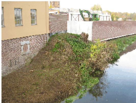
(onder) ontgraving talud noordoostelijk langs Gennepermolen
