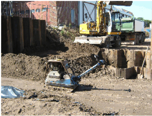
(boven) ontgraving en aanvulling trappartij noordwestelijk van Gennepermolen
