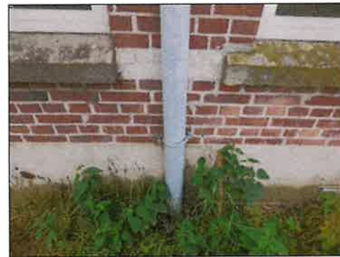
Verzinkt stalen ondereind hemelwaterafvoer
