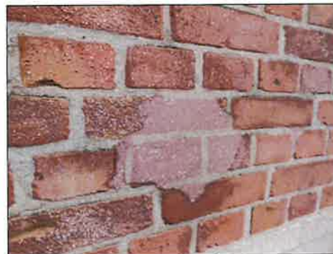
Gerepareerd voeg- en metselwerk
