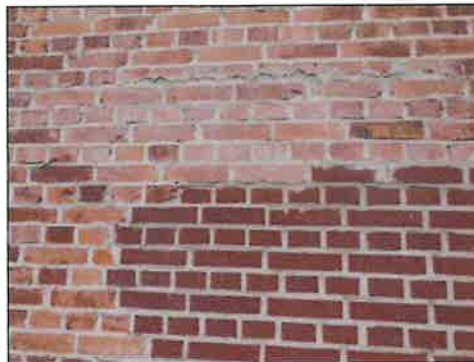
Verschillende formaten gevelstenen
