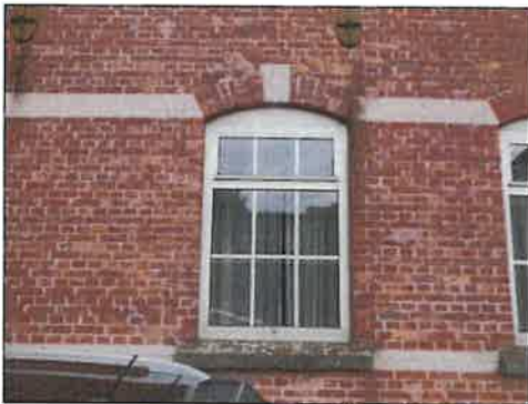
Bestaande aluminium gevelkozijnen
