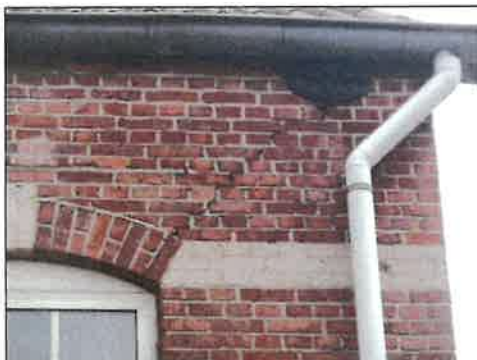
Diagonale scheur (trapsgewijs)
