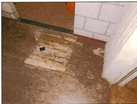
Sparing in de vloerafwerking op de begane grond, houten vloerdelen zichtbaar
