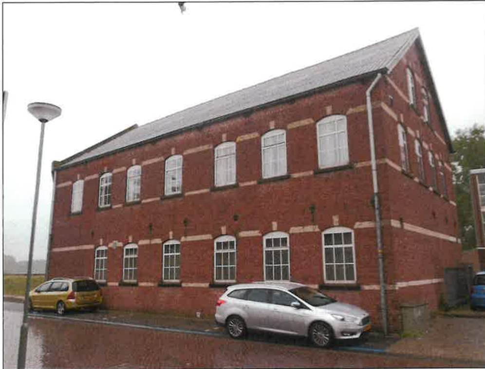
Afbeelding 5, Overzichtsfoto Noordwest gevel
