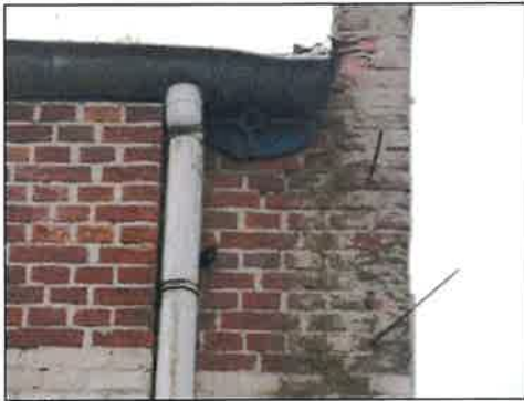
Zinken mastgoot opgehangen aan gootbeugels
