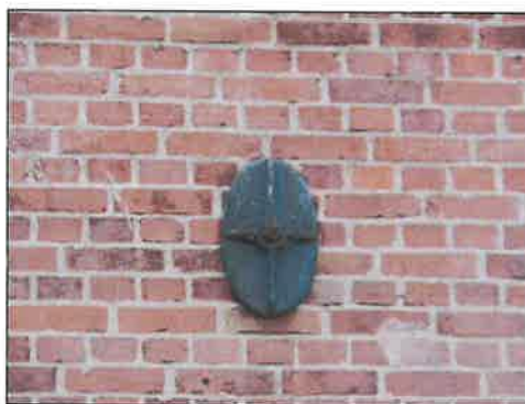
Gietijzeren rozet
