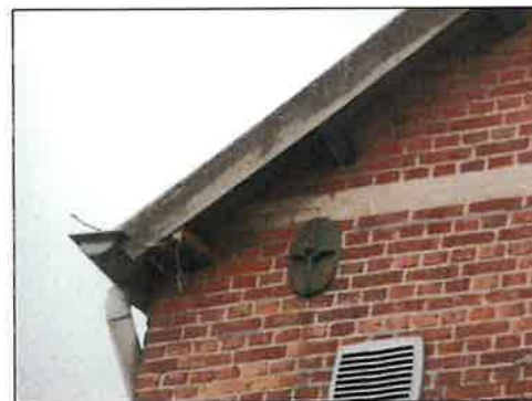
Delen vervangen door wind- en dekveren
