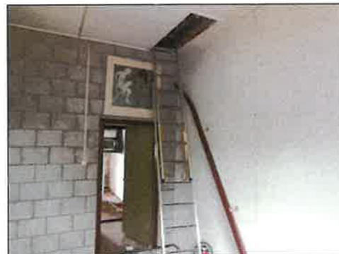
Toegangsluik naar de zolderverdieping
