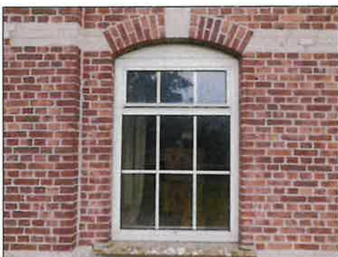
Kunststof gevelkozijnen v.v. geïsoleerde beglazing
