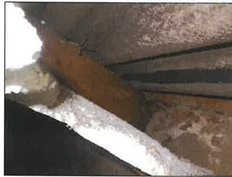
Houten gording, isolatie en golfplaten
