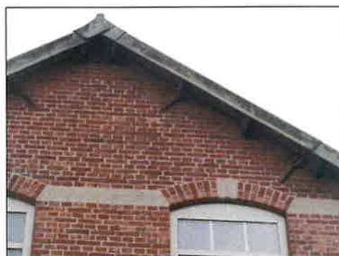
Dakrandafwerking golfplaten
