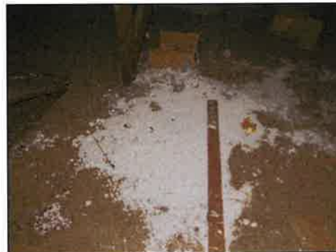
Isolatiemateriaal op de vloer
