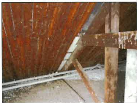
Dakconstructie aan de binnenzijde afgetimmerd
