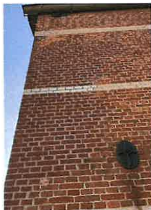
Figuur 2. Ingeboet metselwerk t.b.v. herstel
