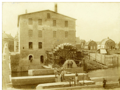
Woningen op de dijk: 1899
