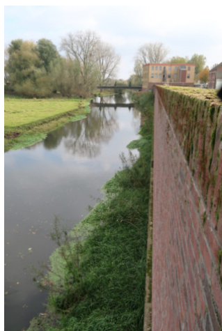
Groene zone naast Gennepershuisweg, de opstaande rand is de bovenkant van de muur langs de Niers.
