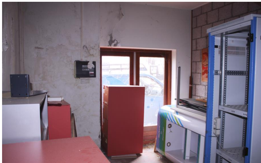
De vestibule op de begane grond aan de westzijde van het gebouw, gezien richting het noorden.
