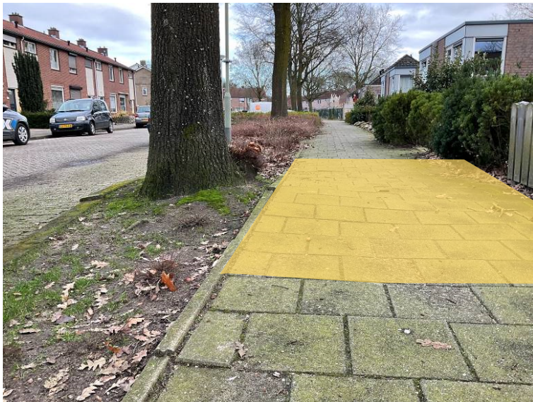
Foto 13: Impressie aan te brengen halfverharding ter hoogte van de moseik met boomnummer 5, aangegeven met oranje markering.
