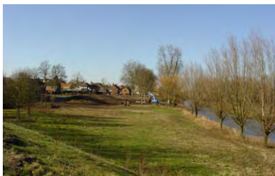
Maaswerken, verhoging kades Niers
