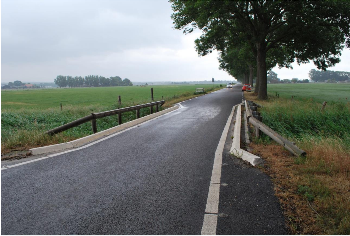
Afbeelding 9: Ringbaan ter hoogte van de toekomstige aansluiting op de Verbindingsweg
