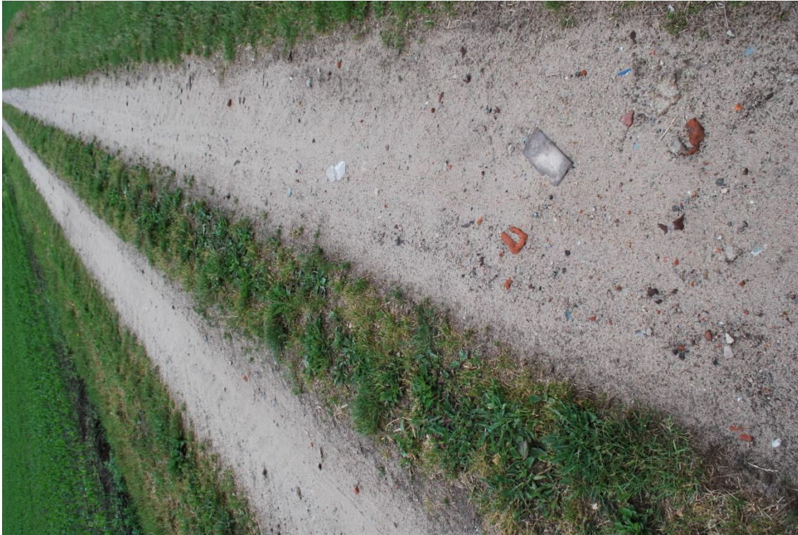
Afbeelding 5: halfverharding Kromsteeg met ongesorteerd puin
