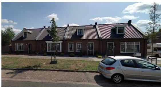
Multifunctionele woningen Destion in Nieuw Bergen.
